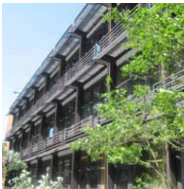
Administrativní budova ArcelorMittal v Esch-sur-Alzette (L)
