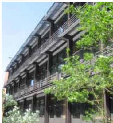
Edificio ad uffici, Esch-sur-Alzette (L)
