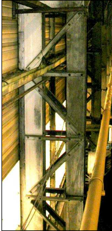
Figura 2.4 Pilar compuesto triangulado en un edificio industrial
