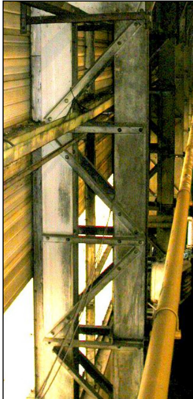
Rysunek 2.4 Słup złożony z kratowaniem w budynku przemysłowym
