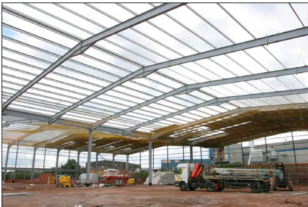
Rysunek 4.1 Płatwie rozpięte między ryglami dachu
