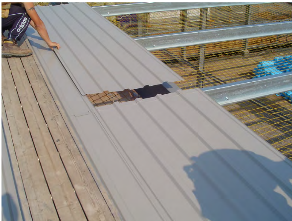
Rysunek 2.4 Instalacja arkuszy okładzinowych wzdłuż rozpiętości płatwi
