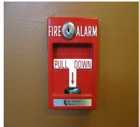
Figura 3.1 Detector y dispositivo de alarma de incendios
