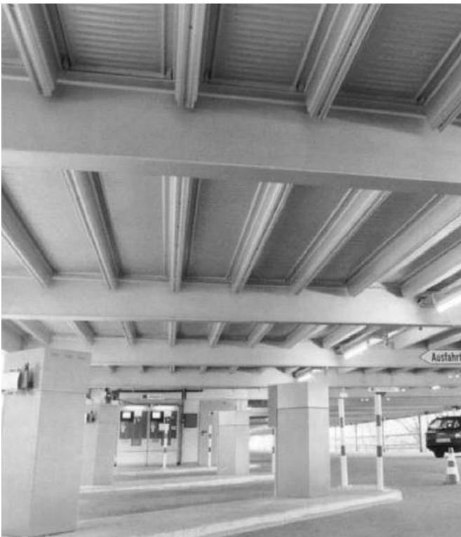
Bild 5. Additive Stahlblech-Stahlbeton-Rippendecke – System Hoesch
