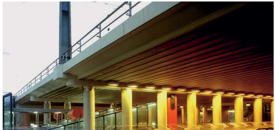
Abb. 1: WIB-Brücke als Durchlaufträger
