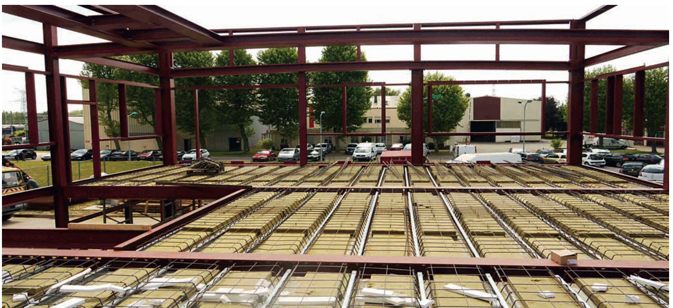
Bild 8. CoSFB + Cofradal 200, Maizières-lès-Metz, France Fig. 8. CoSFB + Cofradal 200, Maizières-lès-Metz, France
