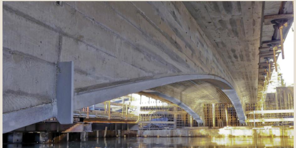
Die Konstruktionshöhe beträgt in Brückenmitte 0,70 m und am Widerlager 1,40 m. Die Gründung des Bauwerks erfolgte als Tiefgründung mit je fünf Bohrpfählen  $\varnothing 90$  cm und Längen von 7,50 m. Die Bemessung erfolgte nach DIBt-Zulassung Z-26.4-56, die speziell für diese Bauweise gilt.
