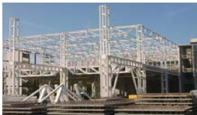
Figure 7 : Chantier de construction type d'une structure en acier avec éléments préfabriqués
