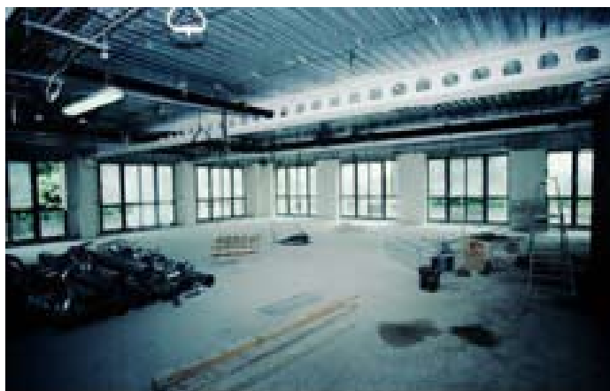
Figure 3 : Espace ouvert et flexible grâce aux grandes portées des poutres en acier
