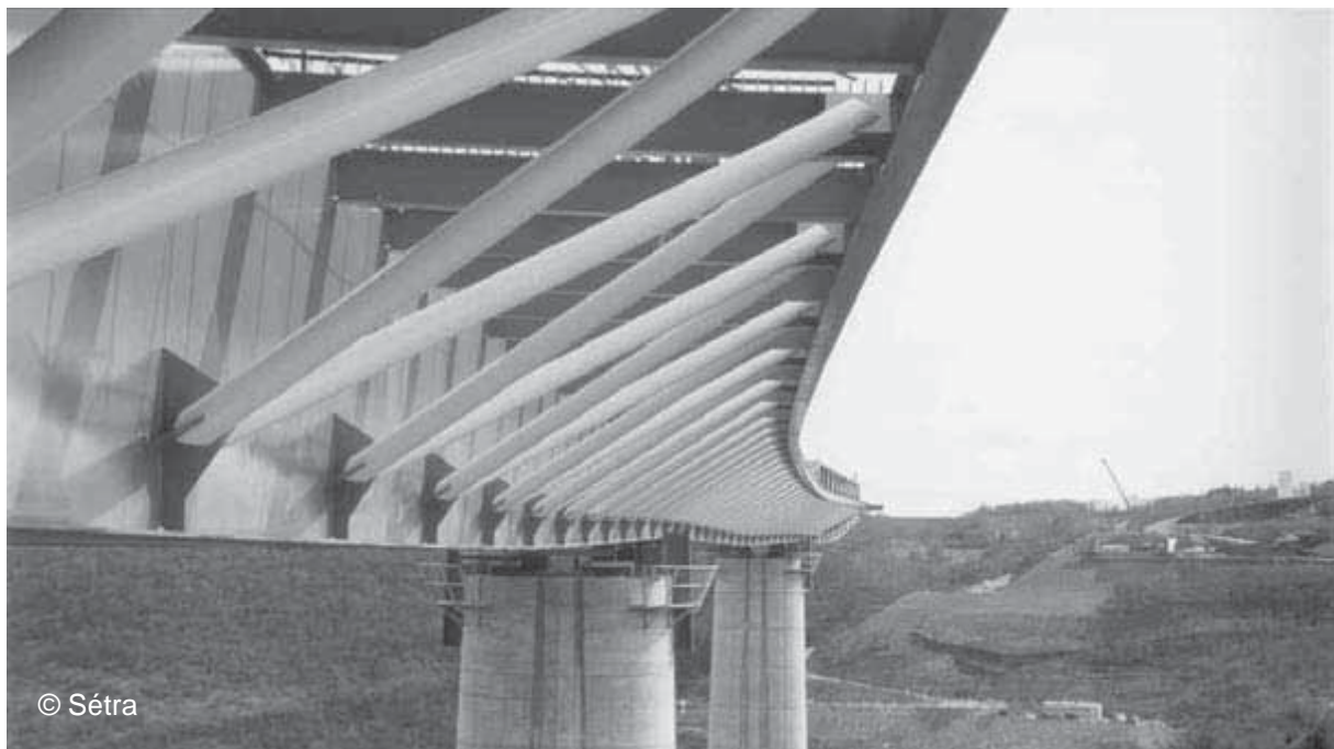
Figure 2.2 : Pont à poutre-caisson avec poutres de rive supportant le tablier Viaduc de Verrières sur l'Autoroute A75 près de Millau, France.
