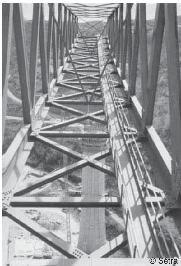
Figure 7.9 : Avant-bec pour le lancement du viaduc de Verrières, près de Millau, France.
