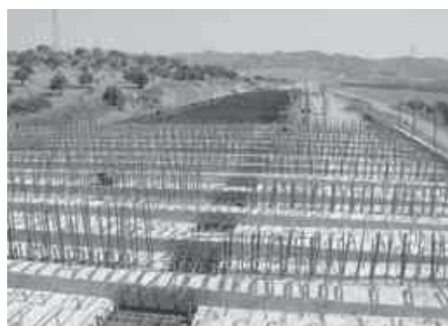
Dalles préfabriquées pour la semelle supérieure
