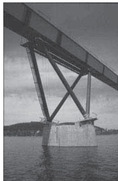
Figure 2.70 : Pont du Vallsundet, Suède (à gauche) et appuis triangulaires sur le chenal de navigation (à droite)
