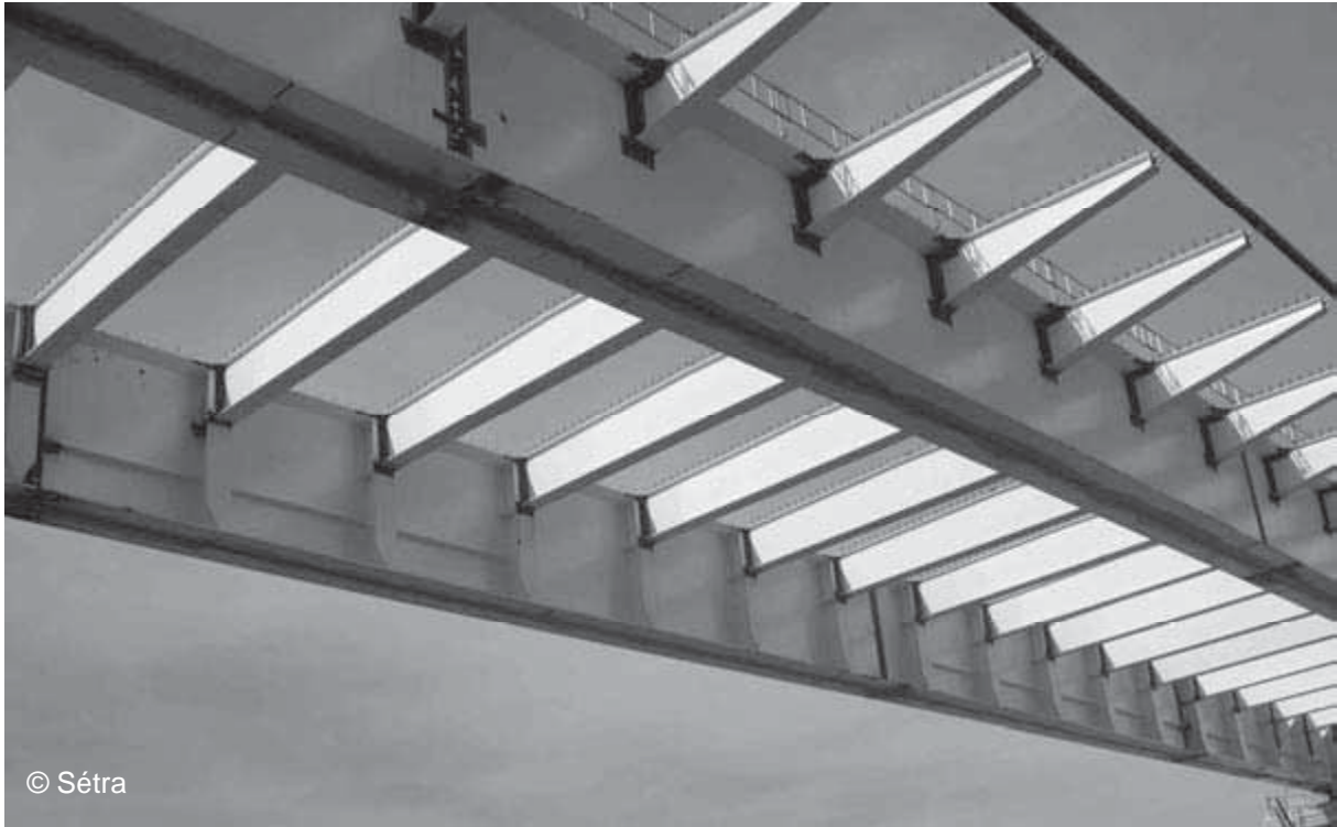
Figure 6.3 : Pont bipoutre près d'Avignon, France, 2008.
