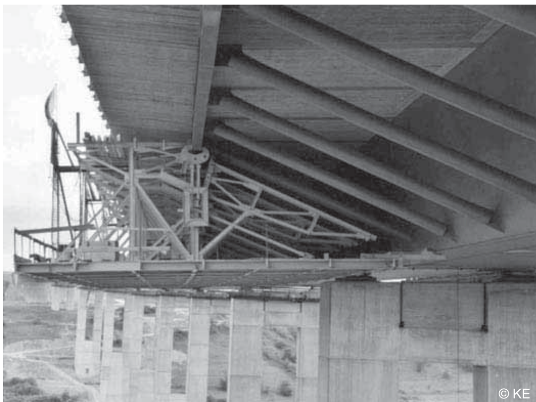
Figure 2.39 : Pont de la vallée Schwarza, Allemagne, 2002. Vue des panneaux repliables du coffrage
