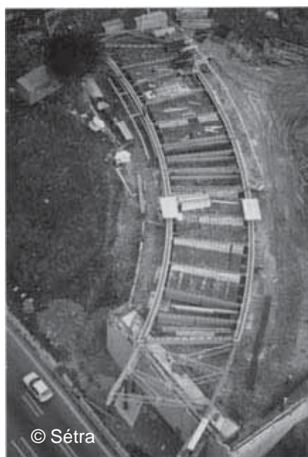
a) Lancement d'un pont courbe, près de Cannes, France
