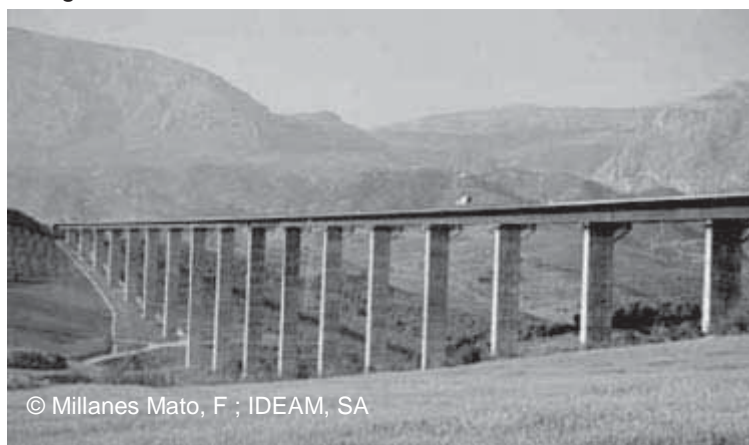
Figure 2.56 : Le viaduc Arroyo de las Piedras [61]
