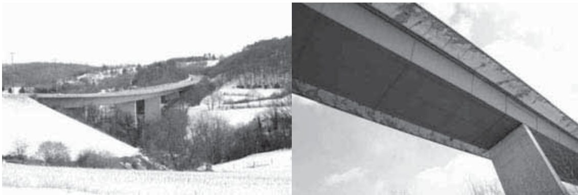
Figure 2.16 : Viaduc de Polleur, Belgique
