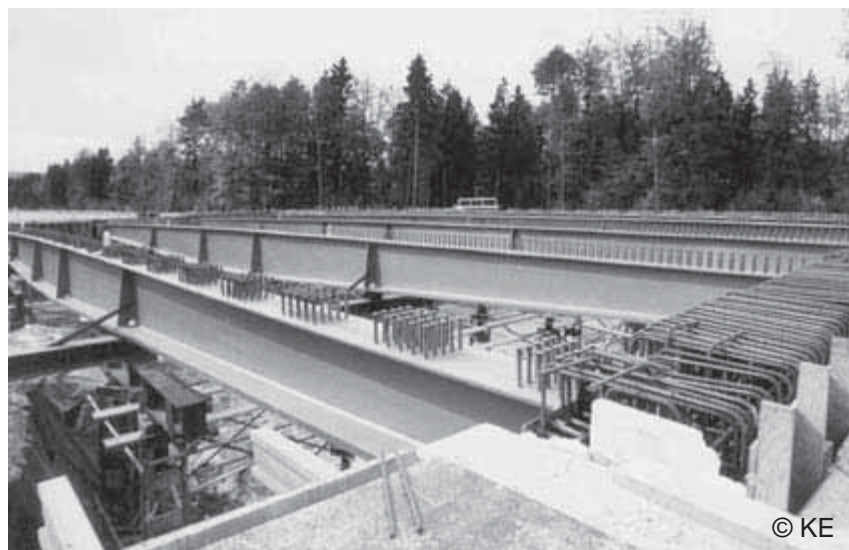
Figure 2.44 : Montage d'un pont à poutres en acier et éléments en béton préfabriqués près de Ravensburg, Allemagne.
