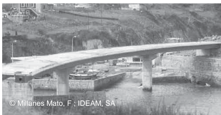
Pont sur la Rià de Ceirvana, Bilbao, 1978 Première utilisation de l'action doublement mixte dans le monde
