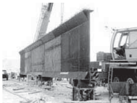
Poutre à cellules triangulaires externes
