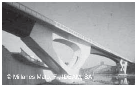
Pont del Diablo, Barcelone, 1972 Portée de 100 m Caissons mixtes triangulaires jumelés
