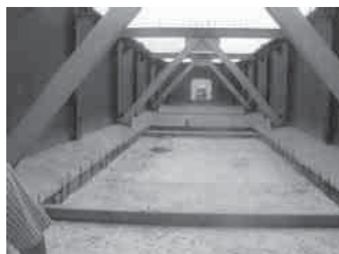
Dalles préfabriquées et béton coulé sur chantier pour la semelle inférieure
