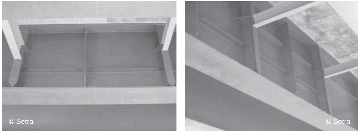
Figure 5.6 : Pont bipoutre de Triel-sur-Seine, France, 2003.
