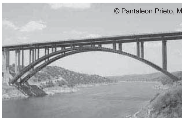
Pont sur le rio Tajo : section en caisson doublement mixte [51]
