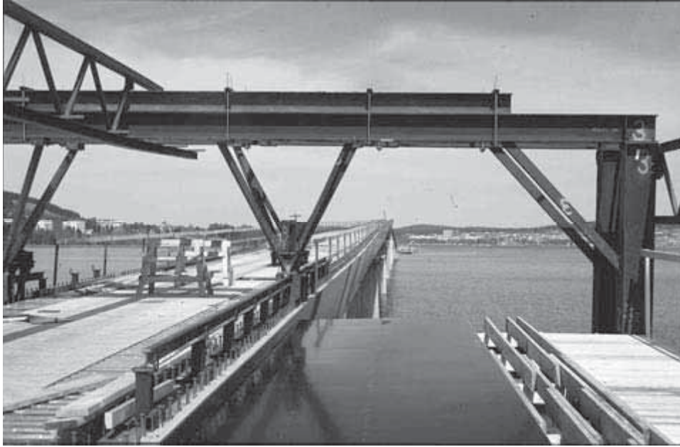
Figure 2.71 : Coulage du béton de la dalle
