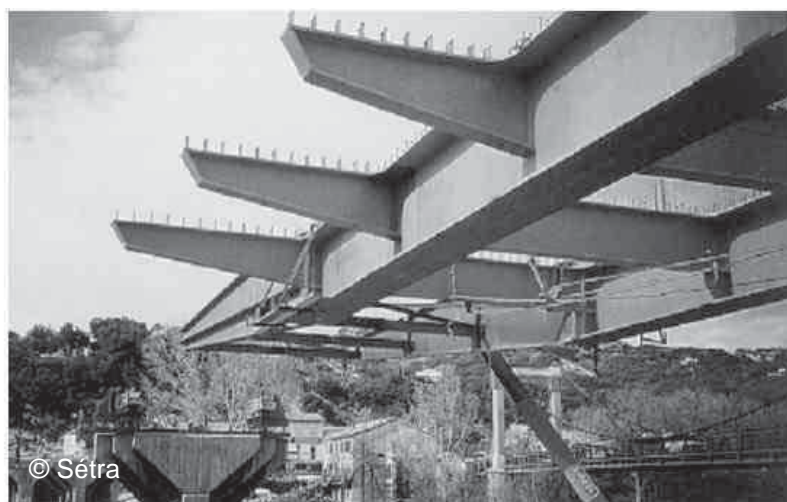
Figure 2.1 : Pont à poutres en I avec tablier large supporté par des traverses en console Pont près de Remoulins, France
