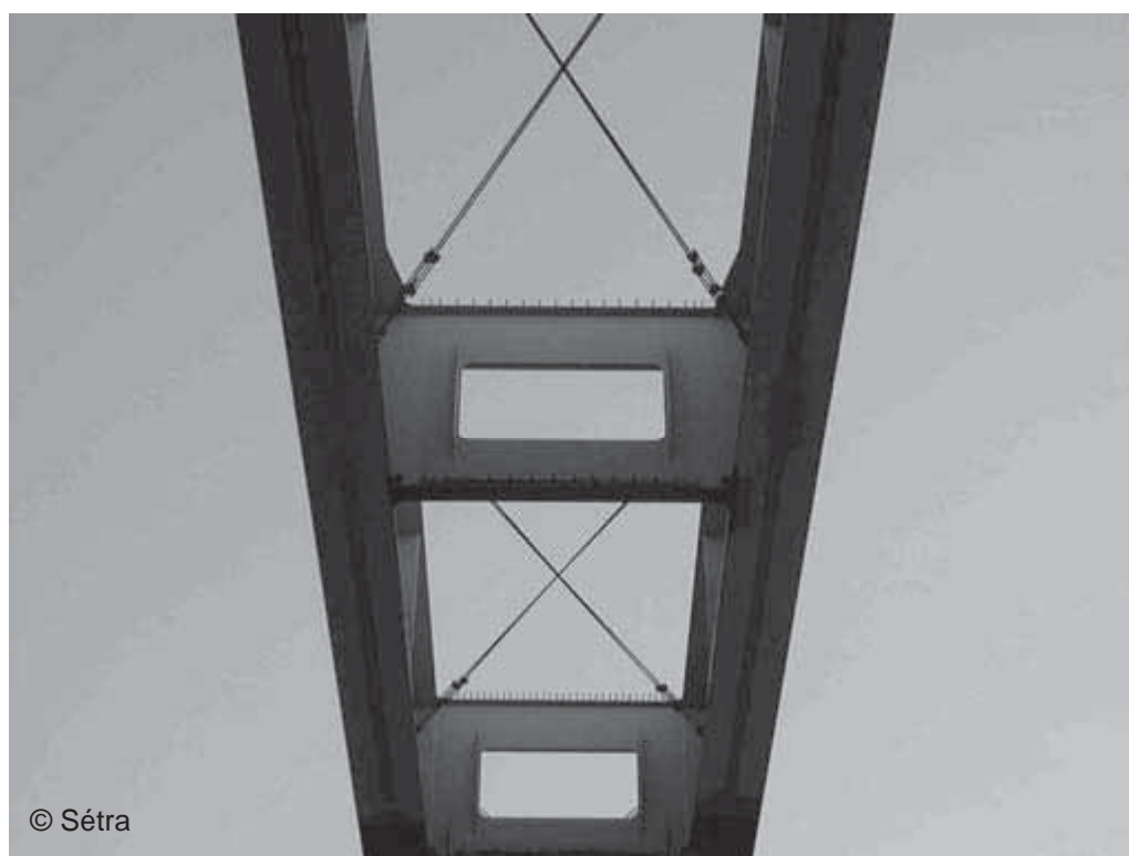
Figure 6.6 : Pont rails bipoutre – TGV Est – Pont-à-Mousson, France.
