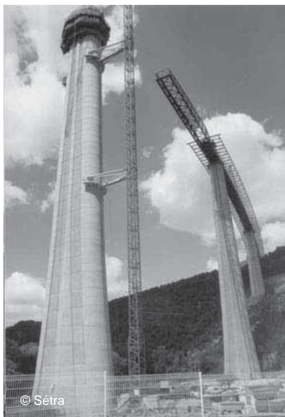
Figure 7.9 : Avant-bec pour le lancement du viaduc de Verrières, près de Millau, France.
