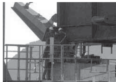
Franchissement d'une pile
