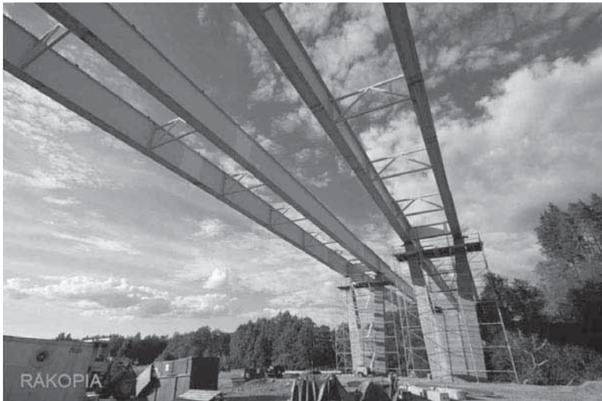
Figure 2.61 : Le pont de Rangedala, Suède, en cours de montage
