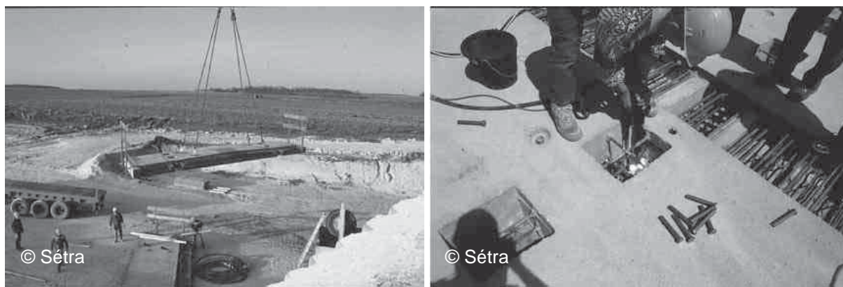
Figure 2.22 : Utilisation d'éléments de dalle préfabriqués
