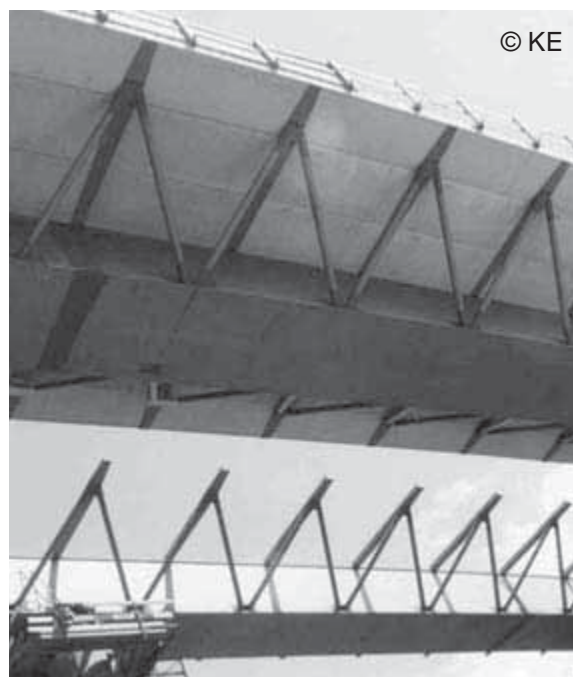
Figure 2.40 : Pont de la vallée Nesenbachtal, près de Stuttgart, Allemagne, 2000
