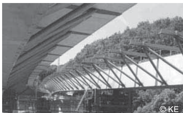
Figure 2.39 : Pont de la vallée Schwarza, Allemagne, 2002. Vue des panneaux repliables du coffrage
