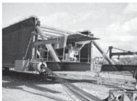
Détail du système de lancement, câbles et vérins
