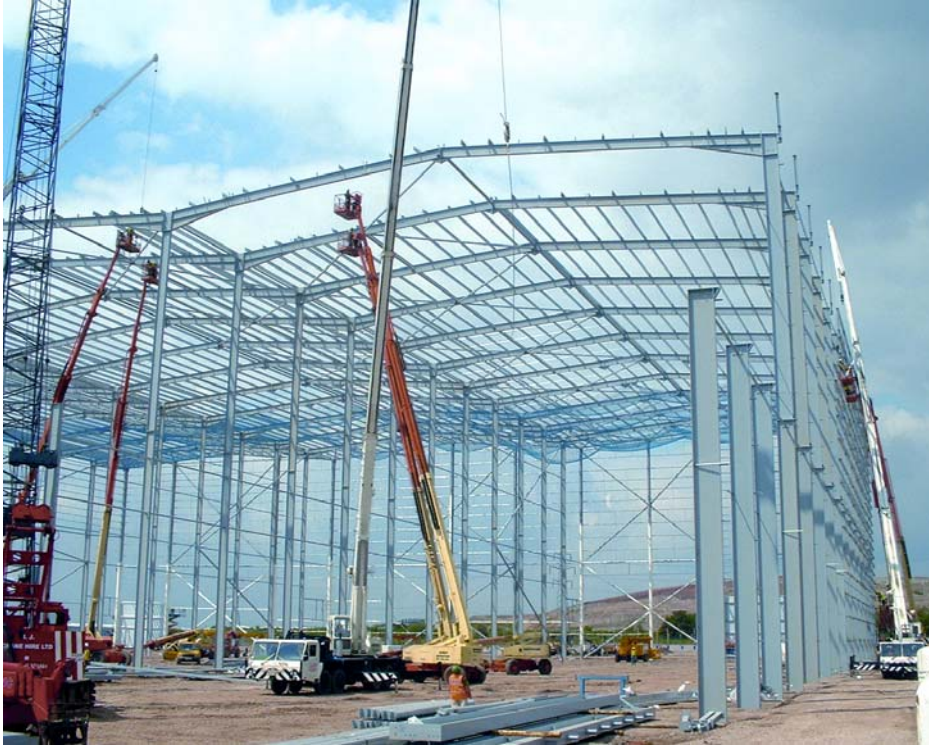
Figure 5.9 Portique avec toit à double pente en phase de montage
